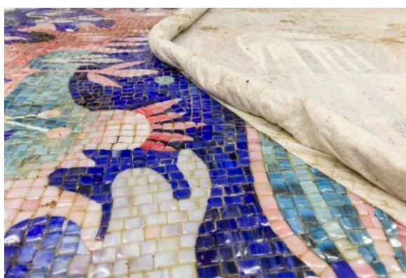
Obr. 19: Snímání gázového přelepu.
