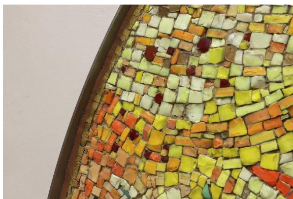
Obr. 38: Detail obvodové dilatační spáry z polyuretanového tmelu.
